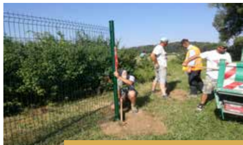
Pose d'une clôture grillagée pour fermer le terrain de foot
