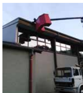
Réfection des planches de rives de la salle polyvalente
