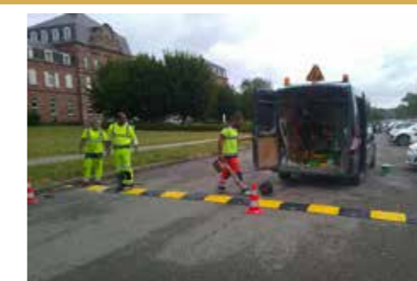
Pose de ralentisseurs sur le parking de la Vierge au Collège
