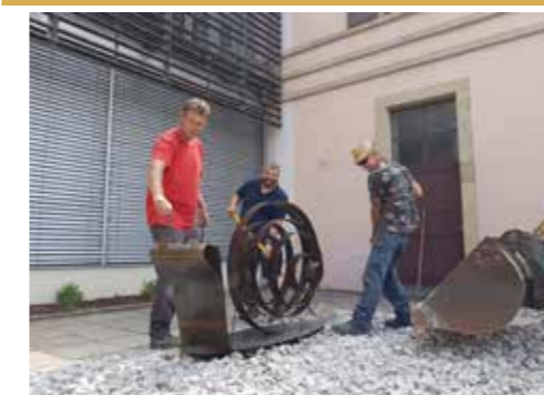
Installation du nouvel escargot Rue de l'Eglise (entrée mairie)
