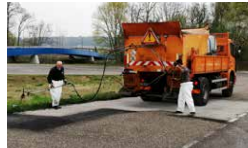
Mise en place d'un revêtement «point à temps» sur le parking de la desserte arrière du Collège Episcopal
