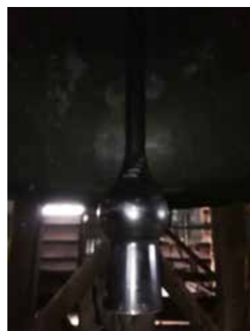
Remplacement du battant de la grande cloche de l'Eglise
